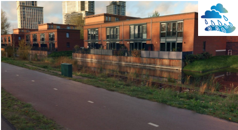
Oosterstraat tijdens de aanleg
